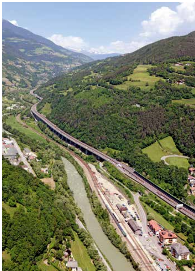
A Ponte Gardena termina il lotto 1 delle tratte di accesso sud della Galleria di base del Brennero.
