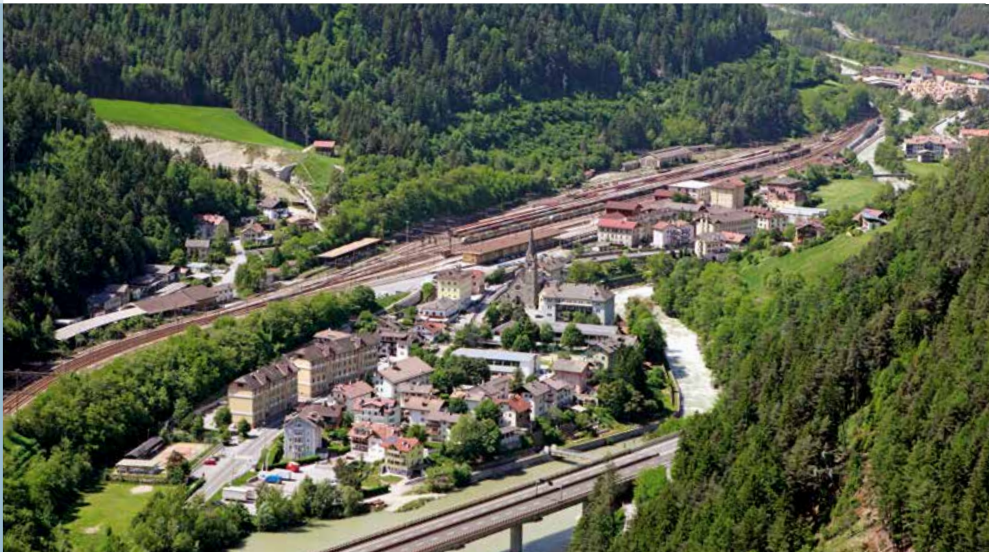
A sud della stazione di Fortezza inizia la galleria che porta verso sud a Ponte Gardena.
