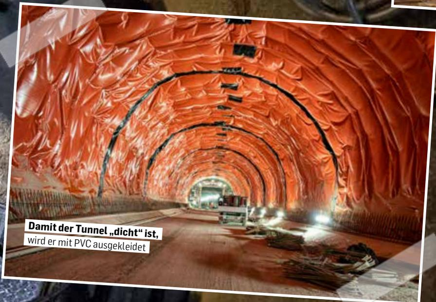
**Damit der Tunnel „dicht“ ist,** wird er mit PVC ausgekleidet
