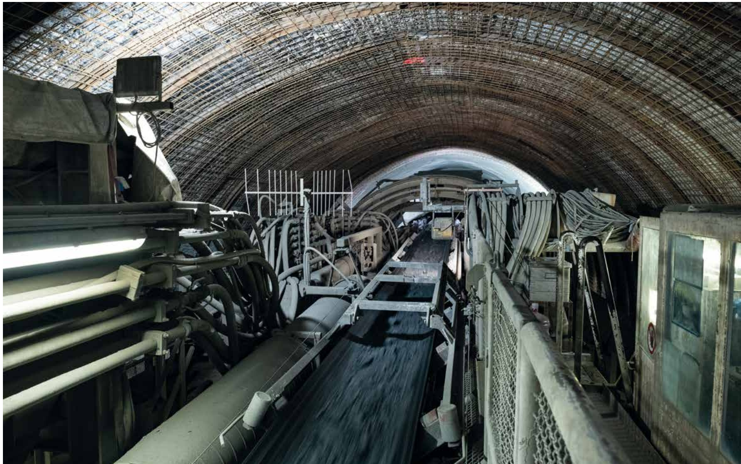
Vorteil der offenen Gripper-TBM: Sicht auf das Gestein Il vantaggio della TBM aperta con gripper consiste nel poter vedere la roccia
