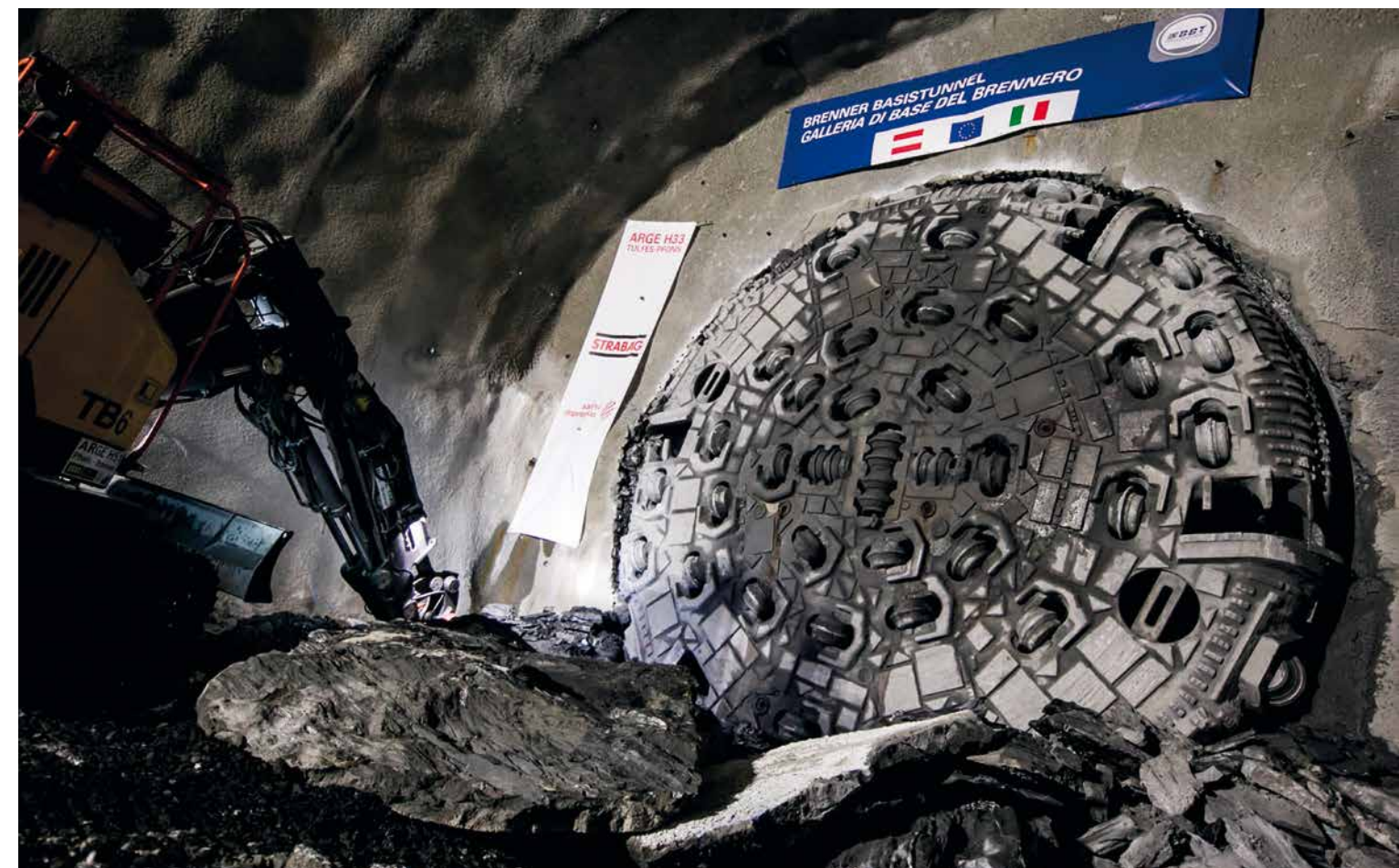
Durchschlag des Erkundungsstollens auf Höhe Steinach am Brenner Abbattimento del diaframma del cunicolo esplorativo al livello di Steinach am Brenner
