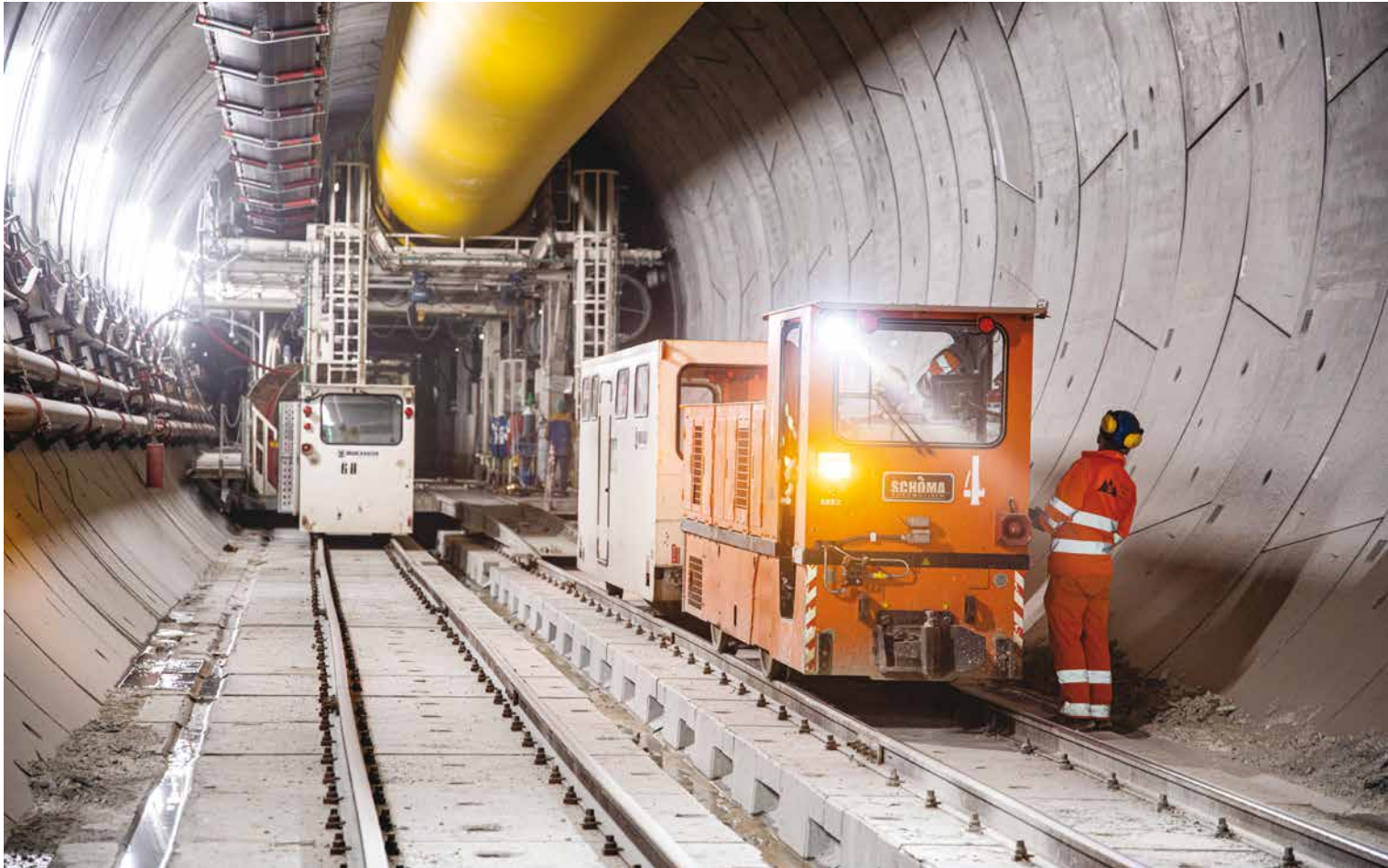
Transportzug im Baulos Mault 2-3. Man beachte die Tunnelauskleidung mit Fertigbetonteilen Treno di trasporto nel lotto costruttivo Mules 2-3. Da notare il rivestimento della galleria con elementi prefabbricati in calcestruzzo
