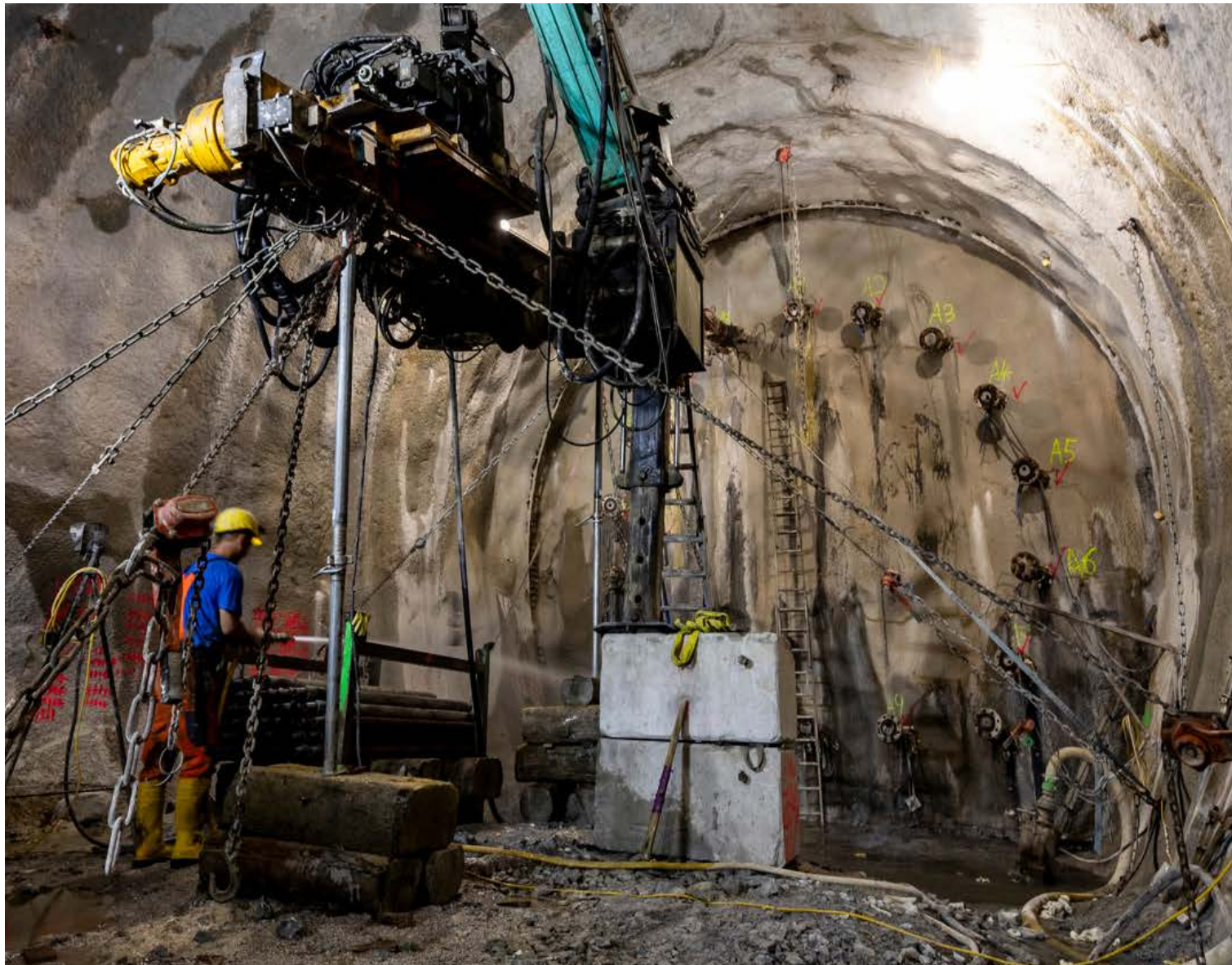
Komplexe Durchörterung der Hochstegen-Zone auf dem Niveau des Erkundungsstollens Attraversamento della zona di faglia di Hochstegen a livello del cunicolo esplorativo
