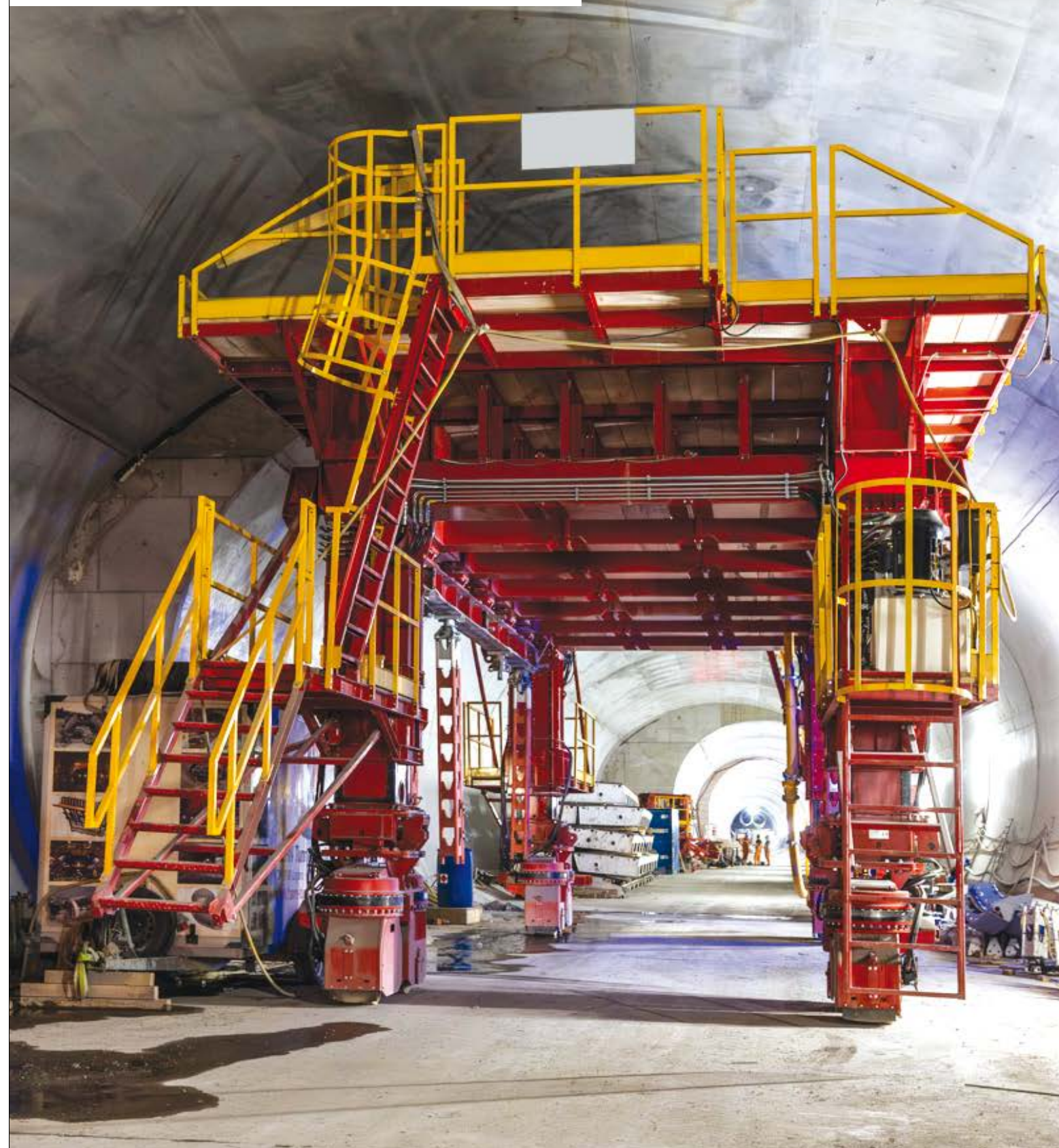
Arbeiten an der Innenschale des Tunnels Lavori sul rivestimento definitivo della galleria
