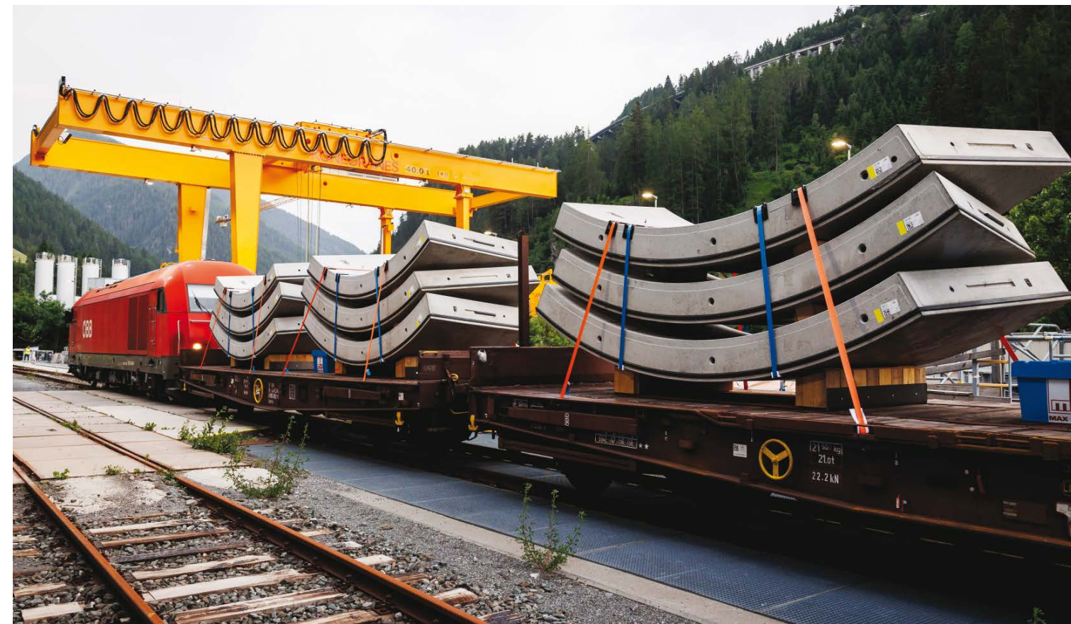
Die in Bayern hergestellten Tübbinge für das Baulos H53 werden per Bahn angeliefert I conci del lotto H53, prodotti in Baviera, vengono trasportati su rotaia
