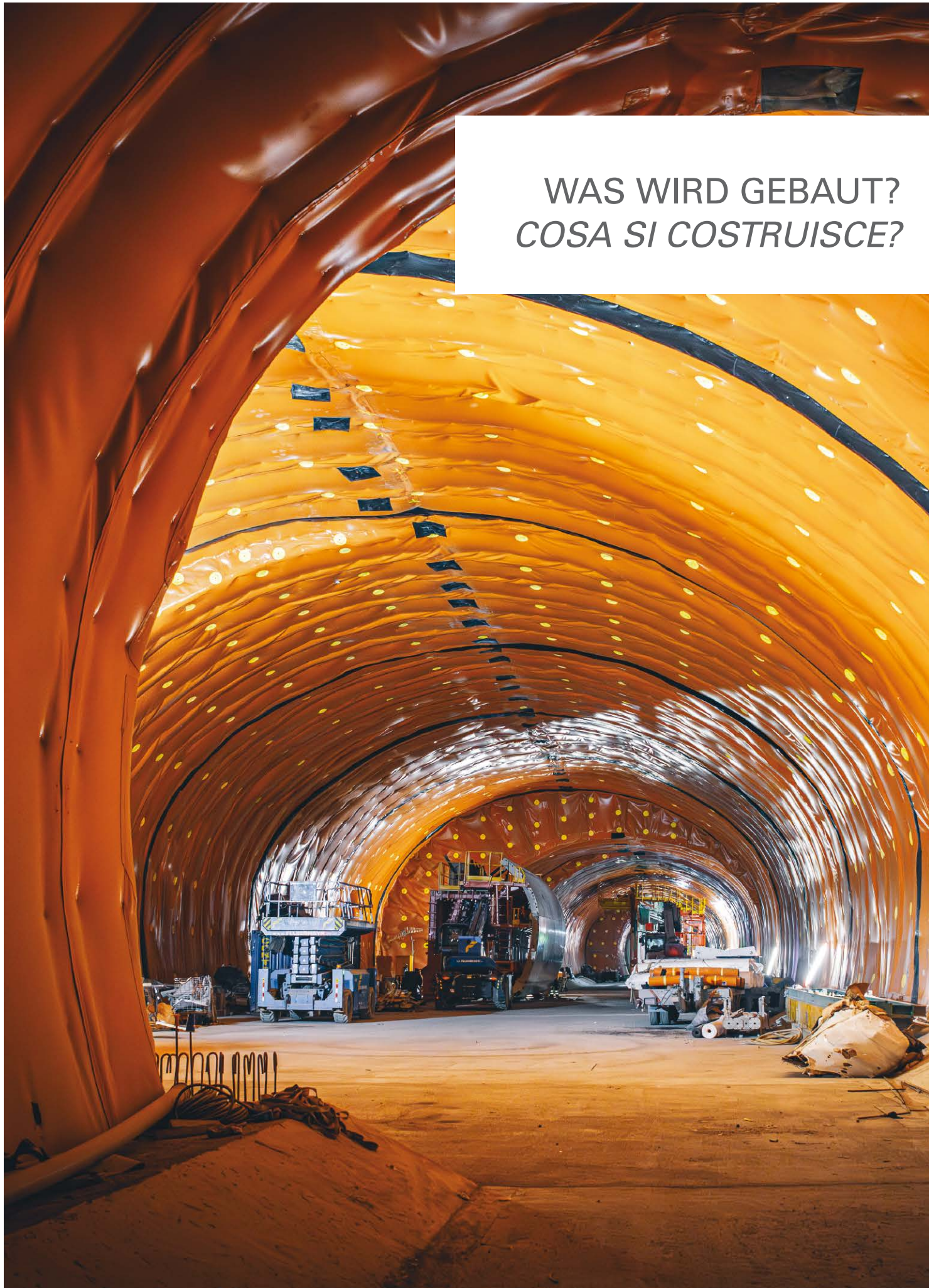
Abdichtungsarbeiten im Bereich der Überleitstelle Lavori di impermeabilizzazione nell'area del posto di comunicazione
