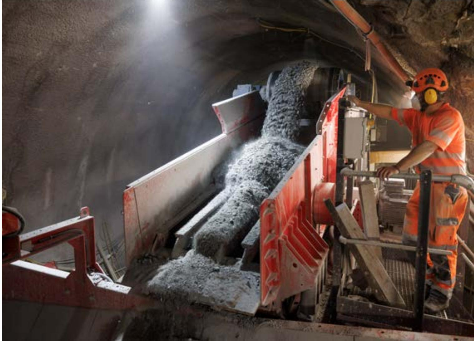
Das Ausbruchsmaterial wird von der Brecheranlage zerkleinert
