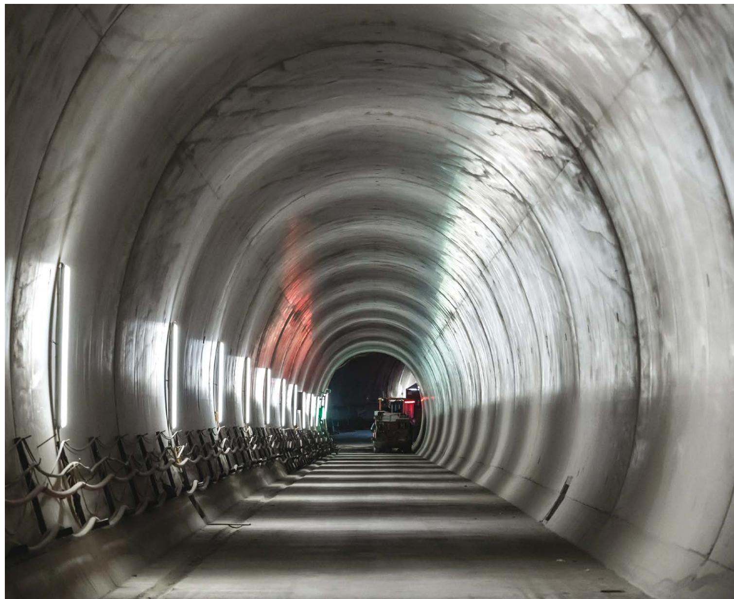
Die Innenschale des Erkundungstollens ist fertiggestellt L'allestimento interno del cunicolo esplorativo è completato
