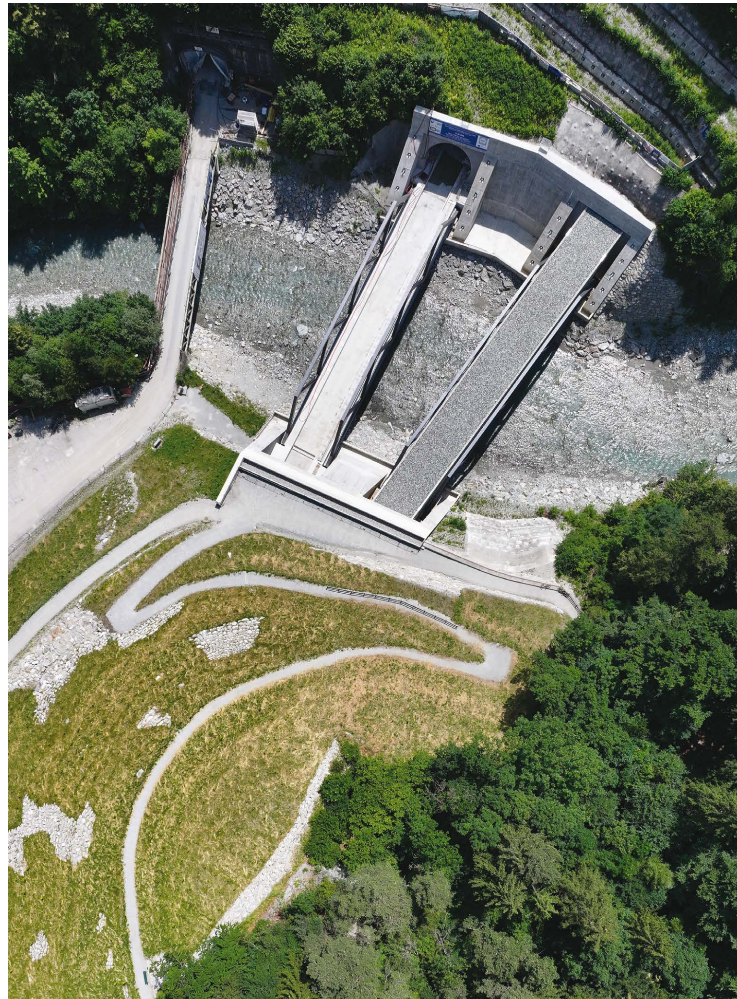
Zwei Eisenbahnbrücken über die Sill binden das Nordportal an, Juli 2025 Due ponti ferroviari sopra il Sill collegano il portale nord, luglio 2025
