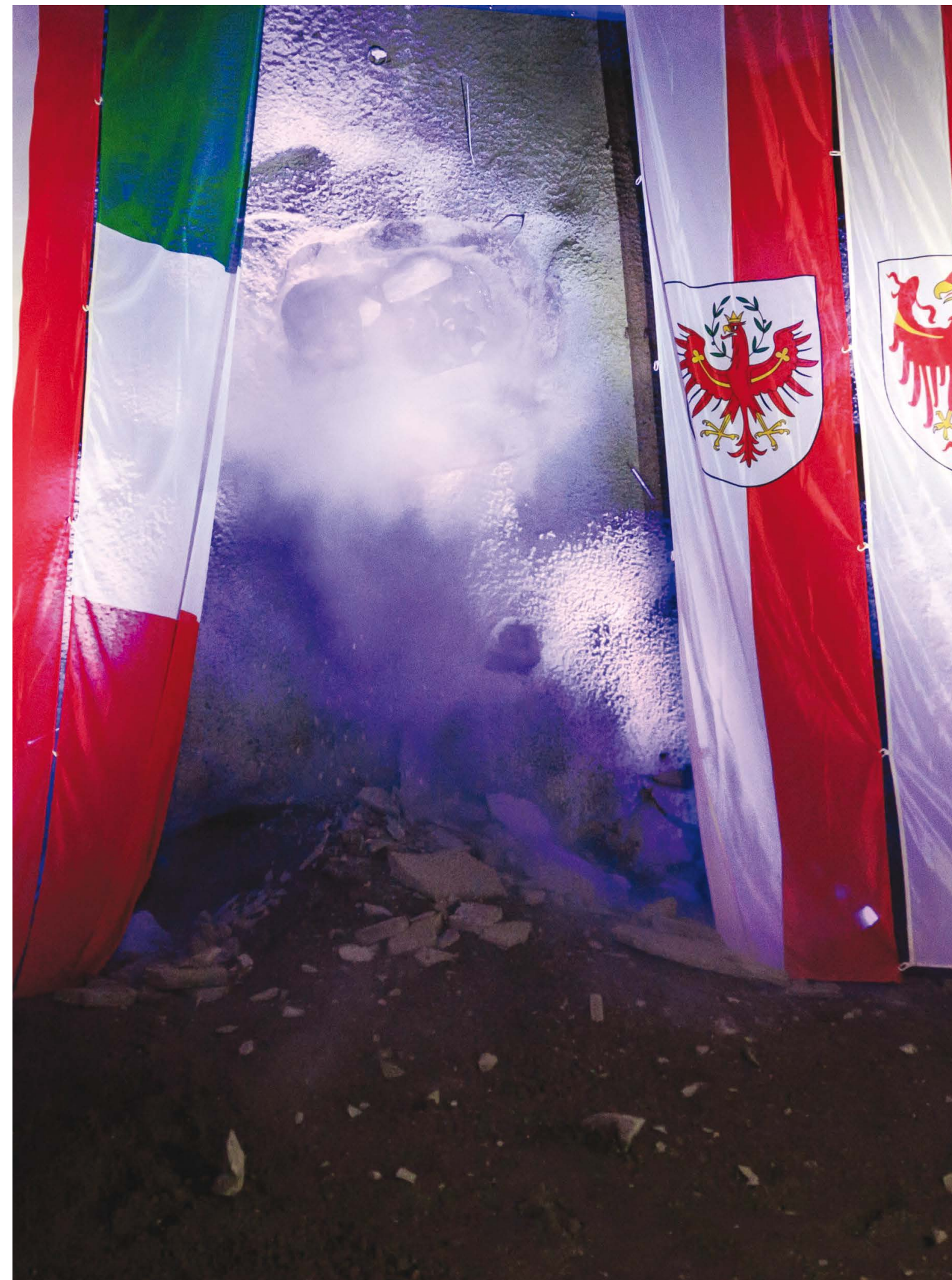
Erster Durchschlag eines Haupttunnels in Österreich am 17. September 2024 Primo abbattimento del diaframma di una galleria principale in Austria il 17 settembre 2024
