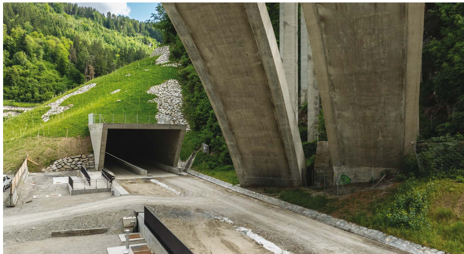
Blick Richtung Süden - unter der A13 Brenner Autobahn hindurch Vista verso sud - sotto l'A13 Autostrada del Brennero
