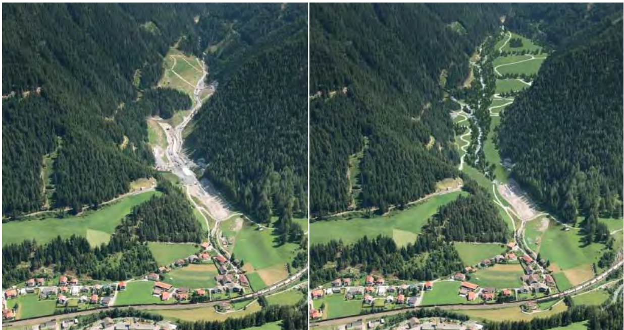
Padastertal 2014: Die Baumaßnahmen (Schutterstollen, Rückhaltebecken etc.) sind abgeschlossen, die Deponierung des Ausbruchsmaterials läuft.
