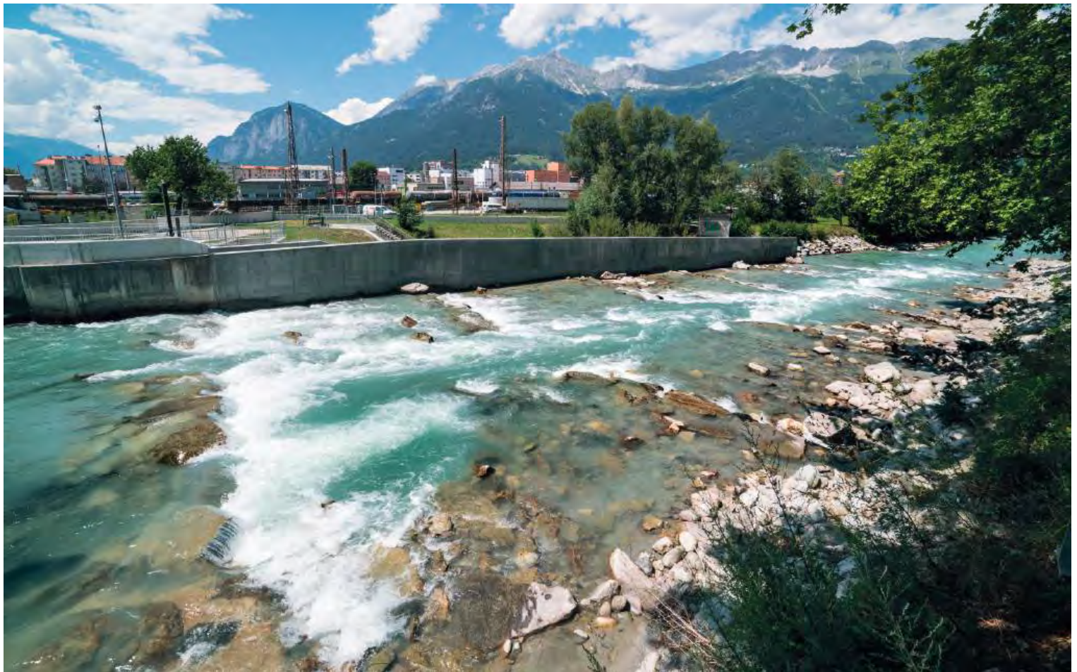
Das Tivoli Wehr befindet sich im Stadtgebiet von Innsbruck und ist ein Anlagenteil eines Laufkraftwerks an der Sill.
