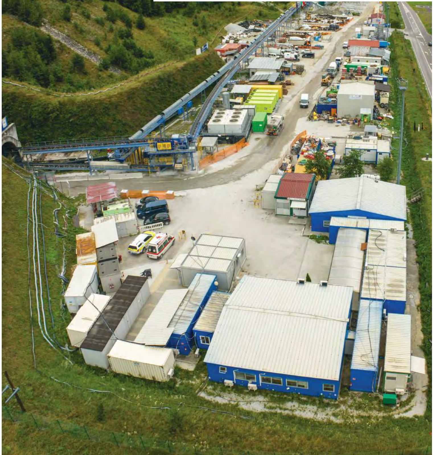
Am Baustellenareal bei Mals werden die Umwelt- und Emissionsschutz-Maßnahmen sichtbar.
