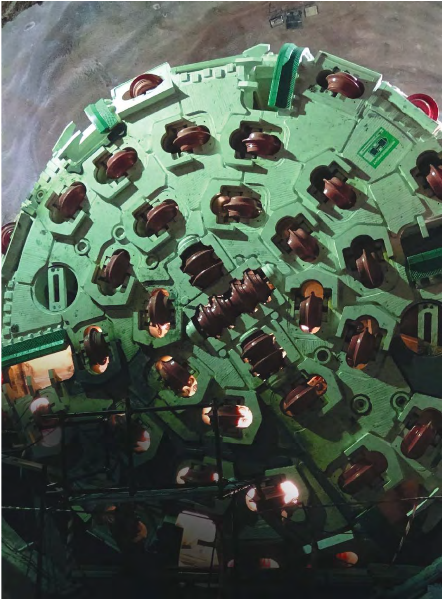
Die Tunnelbohrmaschine „Serena“, welche ca. 14 km Erkundungsstollen zwischen Mauls und dem Brenner ausgebrochen hat, erreichte im November 2021 die Staatsgrenze.
