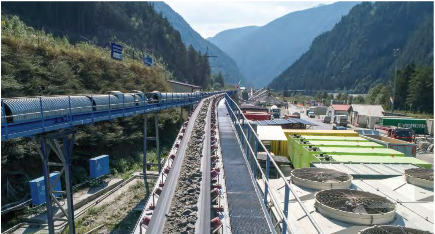
Der Transport des Ausbruchsmaterials erfolgt weitgehend per Förderband.
