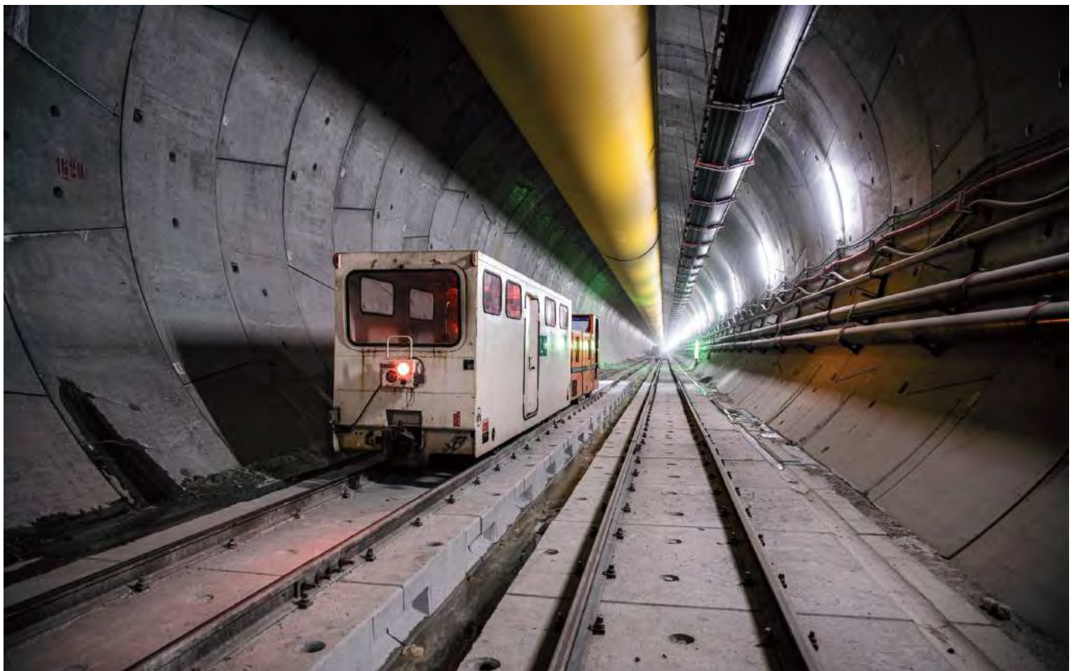
Versorgungszug im Baulos Mault 2-3
