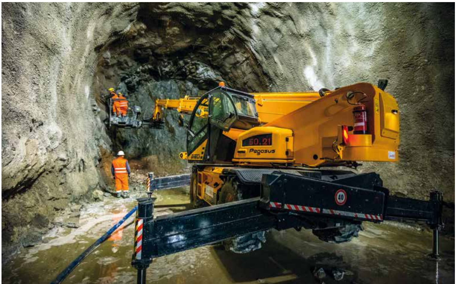
Ortsbrust - bergmännischer Vortrieb Fronte di scavo - metodo tradizionale
