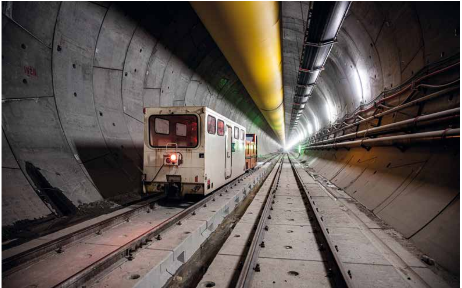
Transportzug im Baulos Mals 2-3. Man beachte die Tunnelauskleidung mit Fertigbetonteilen Treno di trasporto nel lotto costruttivo Mules 2-3. Da notare il rivestimento della galleria con elementi prefabbricati in calcestruzzo
