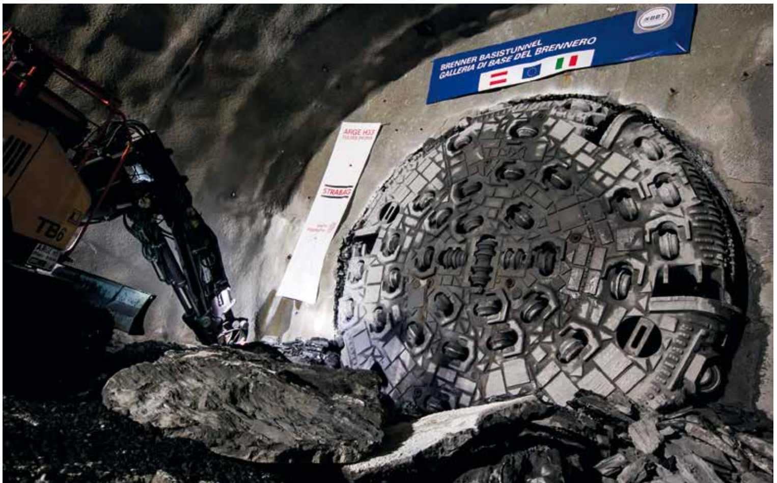
Durchschlag des Erkundungstollens auf Höhe Steinach am Brenner Abbattimento del diaframma del cunicolo esplorativo al livello di Steinach am Brenner
