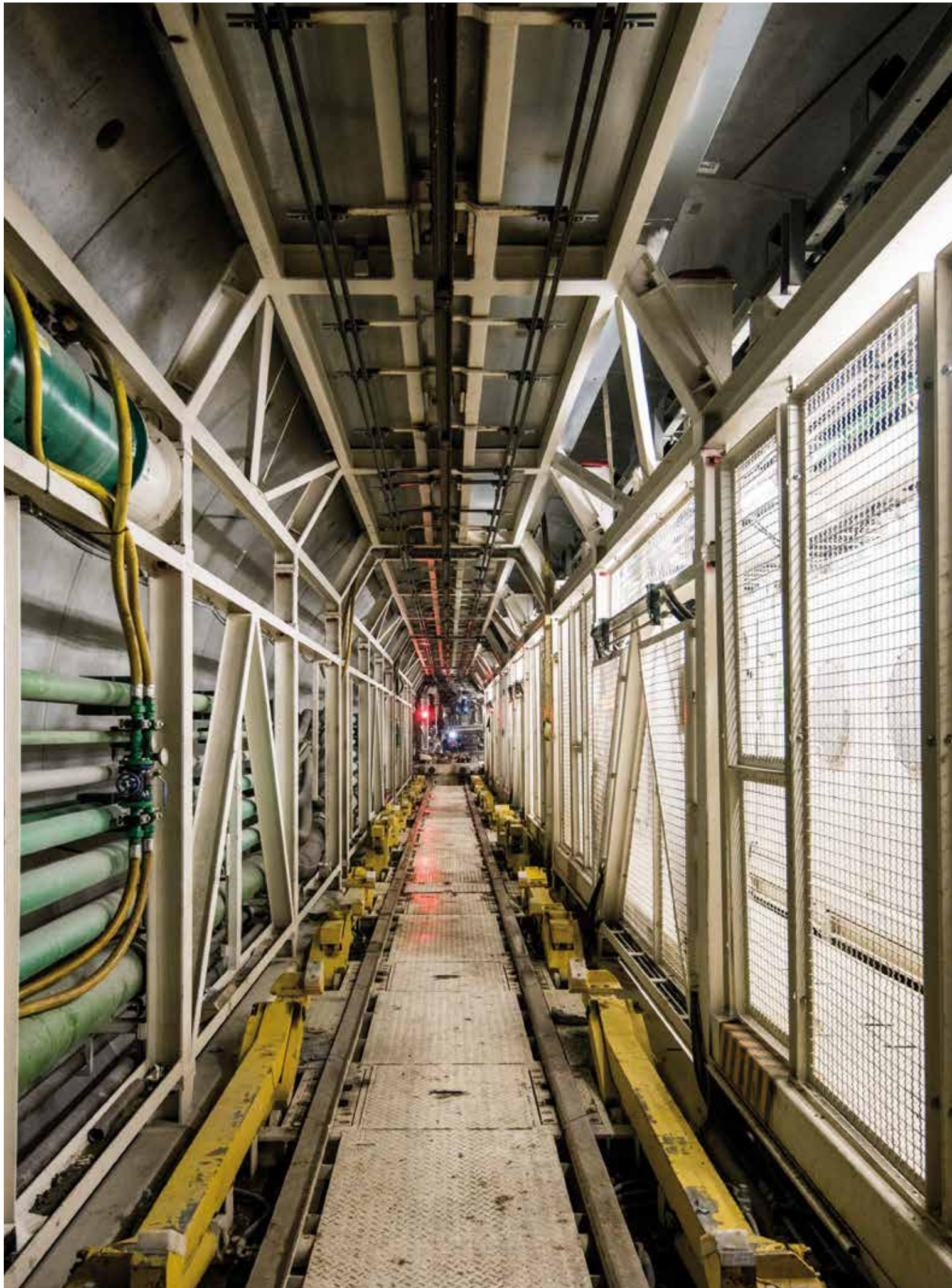
Die durch den Vorschub der TBM gezogenen Nachläufer fahren auf Schienen I carri di backup vengono trainati dall'avanzamento delle TBM
