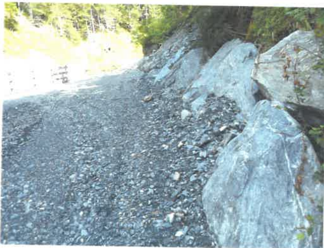
Abb. 3 Mittels Groblöcken gesicherter Hangfuß (Blickrichtung Osten - taleinwärts, im linken Bildbereich ist das Einlaufbauwerk zu erkennen)
