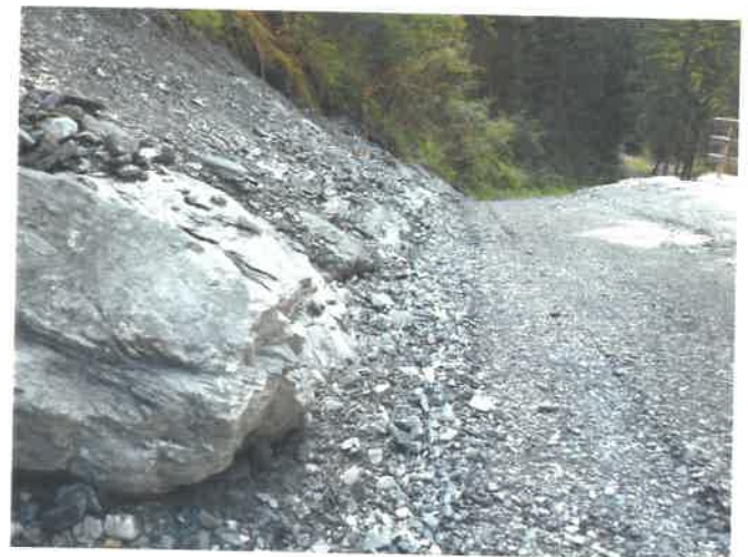
Abb. 3 Mittels Groblöcken gesicherter Hangfuß (Blickrichtung Osten - taleinwärts, im linken Bildbereich ist das Einlaufbauwerk zu erkennen)
