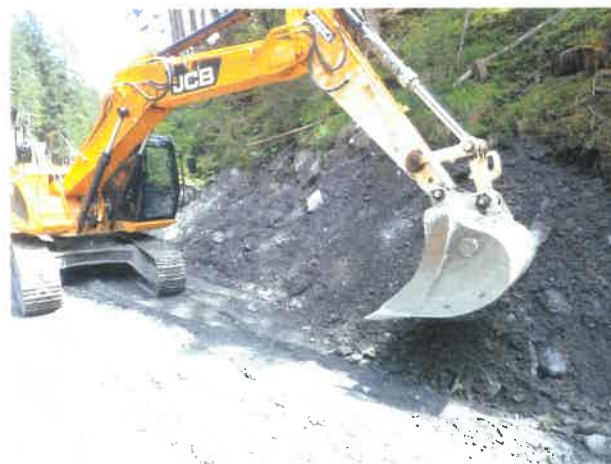
Abb. 2 Hangsituation vor Errichtung Maßnahmen (Stand 22.07.2019)
