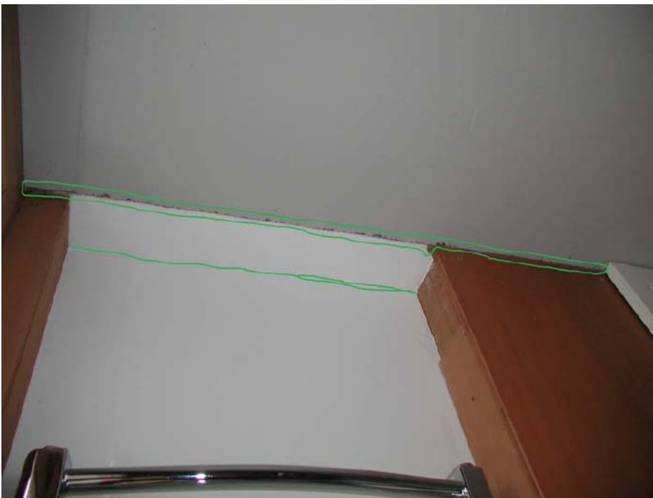
Abbildung 71 ausgefranster Schnitt der Decke und horizontaler Riss in Ichse STB-Teil, Schlafzimmer 2, Blickrichtung West
