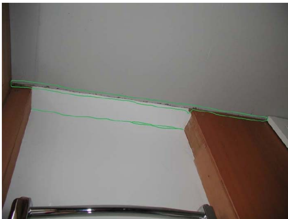
Figura 71 profilo sfaldato del soffitto e crepa orizzontale in convesa di elemento in ca., camera da letto 2, direzione di visuale ovest
