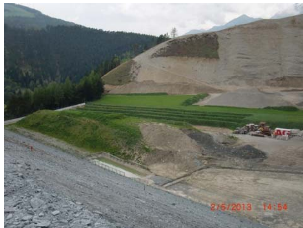
Schüttphase 2.1, Humus-/Zw.bod.mieten, Absetzbecken / fase di riporto 2.1, humus / terreno intermedio, seatoi di separazione
