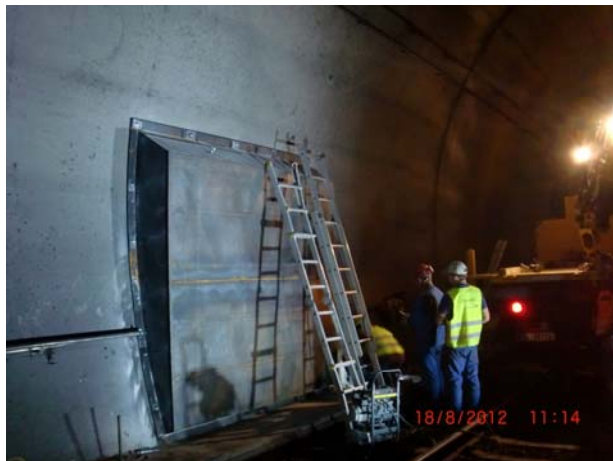
Stahlkästen im Umfahrungstunnel (Anbindung Querschläge) / rivestimenti protettivi in acciaio nella circonvallazione Innsbruck (allacciamento cunicoli trasversali di collegamento)
