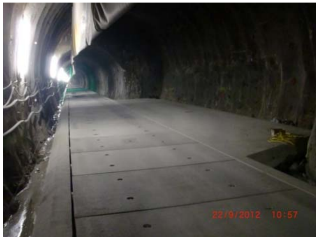
EKS Innsbruck, Sohlausbau (Sohlgerinne, FT-Deckel) / EKS Innsbruck, rivestimento suola (canale di suola, coperchino prefabbricato)
