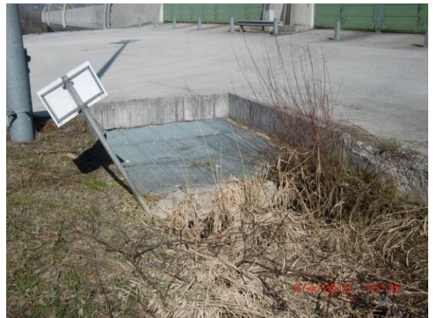
Bestehender Sandfang im Portalbereich / presa esistente di sabbia nella zona portale
