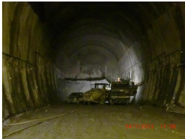
EKS Ahrental, TBM-Montagekaverne / EKS Ahrental, camerone di montaggio TBM
