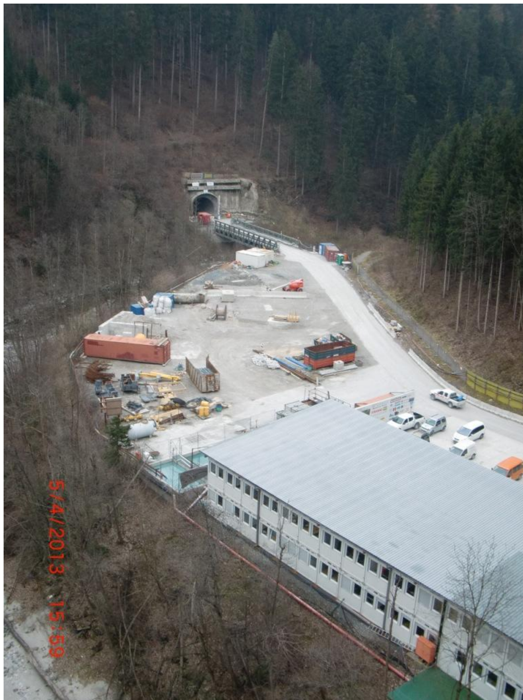
BE-Fläche Sillschlucht (Portal Zugangstunnel Sillschlucht, BE-Fläche, GSA inkl. Ableitung zur Sill) zona cantierizzazione Sillschlucht (portale galleria d'accesso Sillschlucht, zona cantierizzazione, impianti del trattamento delle acque incl. condotta verso Sill)
