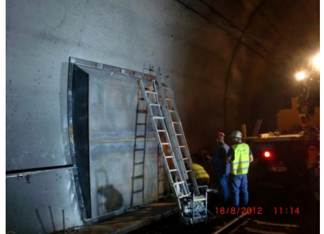
Stahlkästen im Umfahrungstunnel (Anbindung Querschläge) / rivestimenti protettivi in acciaio nella circonvallazione Innsbruck (allacciamento cunicoli trasversali di collegamento)
