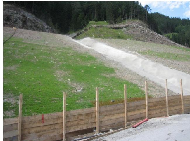
Illustrazione 12 Canale con rivestimento in calcestruzzo progettato per smaltimento acque torrenti laterali sopra deposito su versante 1 (lotto E51).
