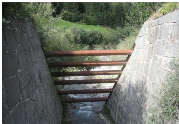
Abbildung 6 Geschiebesperre Bestand (links);
