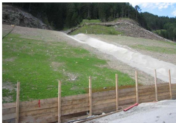
Illustrazione 12 Canale con rivestimento in calcestruzzo proiettato per smaltimento acque torrenti laterali sopra deposito su versante 1 (lotto E51).
