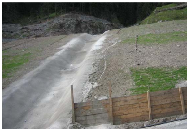
Abbildung 12 Spritzbetonoberflächengerinne Ableitung Seitzubringer bei Schüttphase 1 (Baulos E51).
