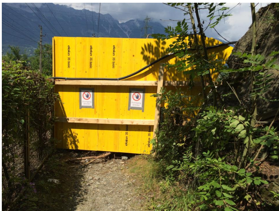
Abbildung 10: Schutzwand an Baustelle Wiltener Tunnel
